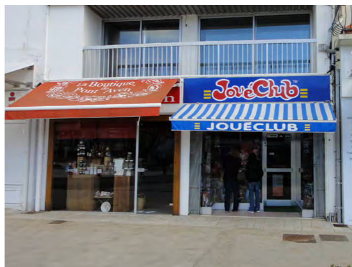
Store avec écritures, au-dessus de l'enseigne bandeau Store bicolore, lettrage trop gros.
