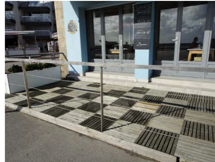
Pose d'un platelage bois Fermeture de la terrasse
